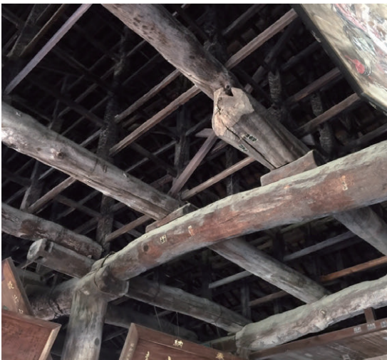
fig.1 千畳閣の小屋組 [撮影 | ビルディングランドスケープ]
