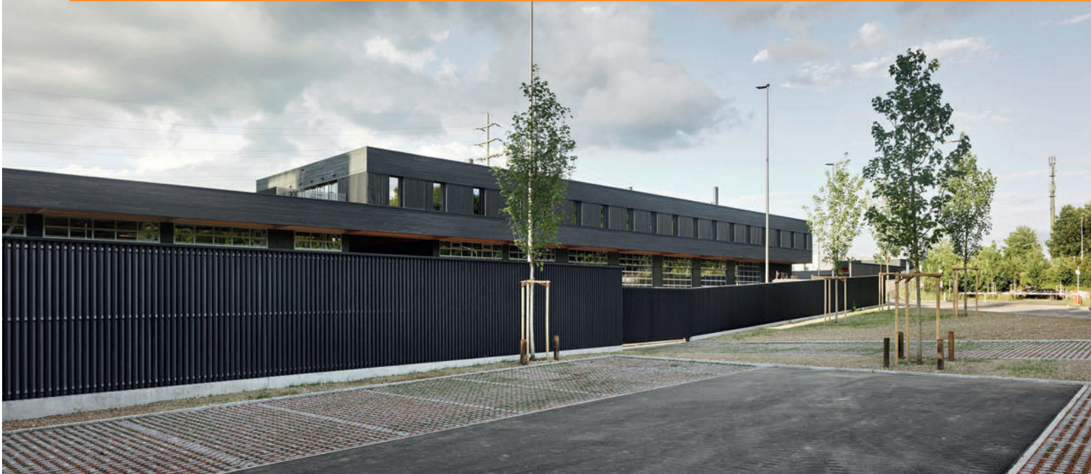
■ Das realisierte Projekt «Linus»: ein elegantes, langgezogenes Gebäude mit geräumigen Hallen und einem darüberliegenden Bürotrakt. (Bild: zVg)
