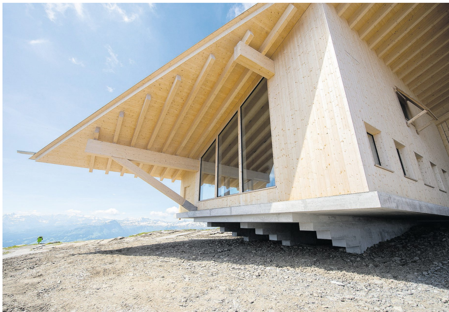
Die imposante, weit auskragende Dachkonstruktion der Bergstation Chäserrugg überzeugte die Jury des Prix Lignum.
